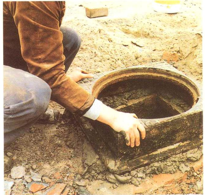
**Beschreibung:** **Watmat** ist ein für sofortige Anwendung fertiges, schnell bindendes Produkt, das aus einer Mischung von speziellen Zementarten, Kieseln und Zusätzen besteht. Seine Eigenschaften bestimmen einen optimalen Anwendungsbereich insbesondere für die Nivellierung von Kanalisationsdeckel bei neuen Konstruktionen und dringende Reparaturen von Fabriksböden.
